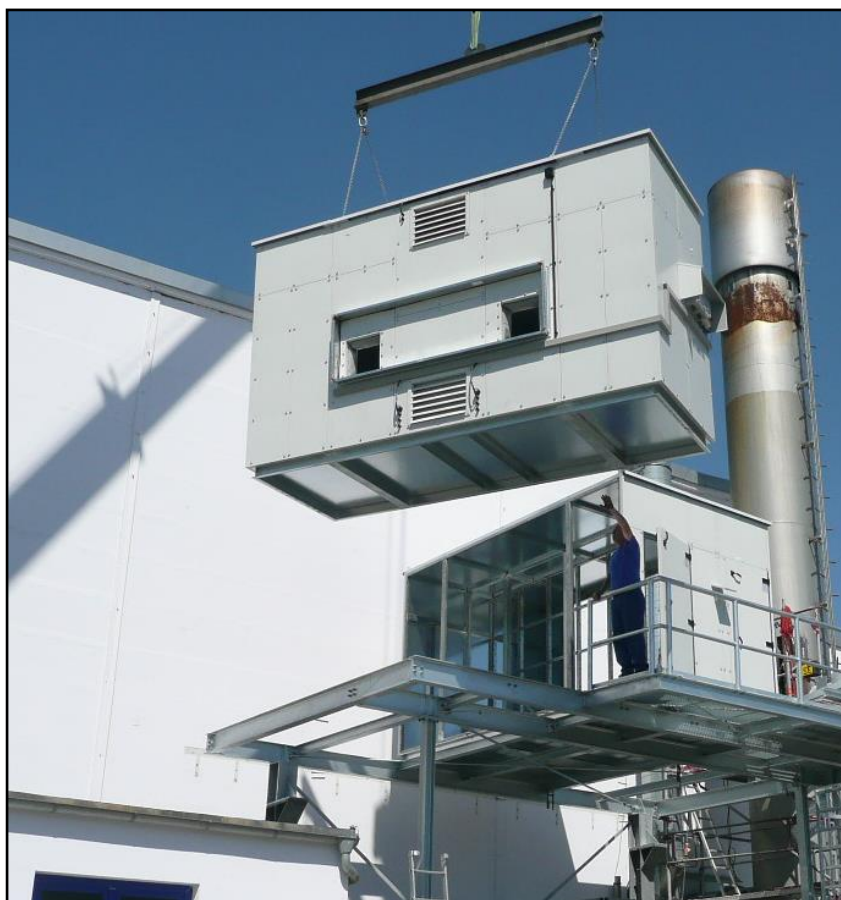
Montage der Abluftanlage
