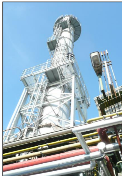
Nicht-Katalytische Entstickung (SNCR), eingebaut in ISO-Container; Schornstein mit Eindüseebene
