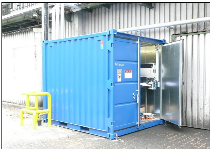
Nicht-Katalytische Entstickung (SNCR), eingebaut in ISO-Container; Schornstein mit Eindüseebene
